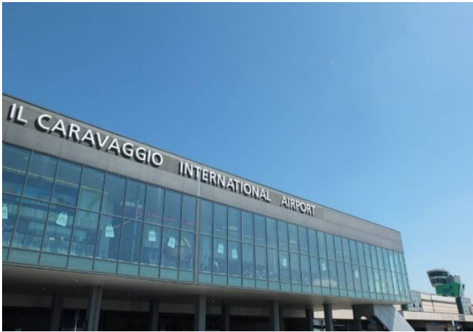
La facciata dell'aeroporto "Il Caravaggio"
